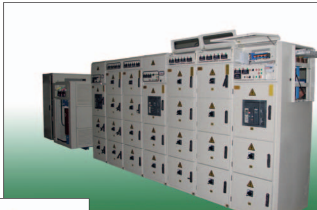
Комплектна двотрансформаторна підстанція 2КТПУ/EL-1000-6/0,4 УЗ з трансформаторами фірми Siemens
